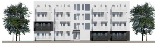
Fassade des Gebäudes
